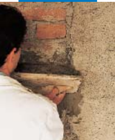
Restaurering av tegelvägg
